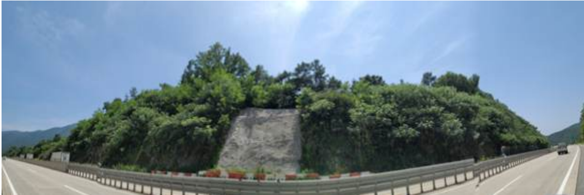
영천절토 12 (관리이정 16.844~17.264km / 3공구 STA.0+830~1+250)
