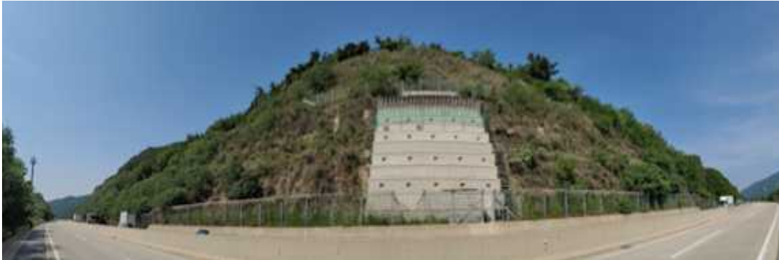
상주절토 14 (관리이정 17.304~17.504km / 3공구 STA.1+290~1+490)
