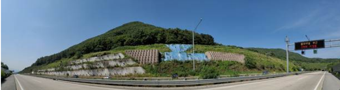
상주절토 16 (관리이정 21.194~22.054km / 3공구 STA.5+180~6+040)
