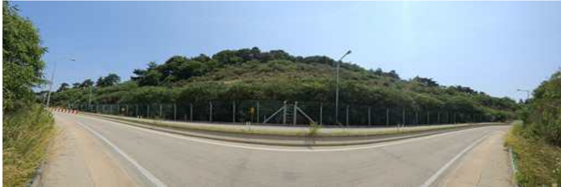
상주절토 07 (관리이정 도개IC R-A 0.070~0.330km / 2공구 도개IC R-A 0.070~0.330km)
